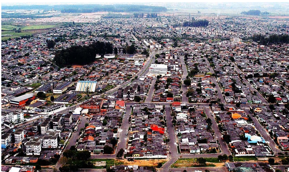
Figura 11 - Imagem do Guajuviras transformado pelos moradores. Fonte: César Barbosa, 2009.
